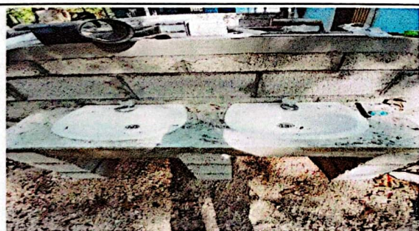
SUSTITUCIÓN DE LAVAMANOS
