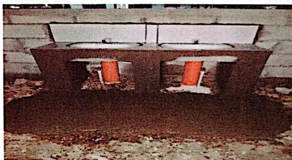
SUSTITUCION DE PISO DE TORTA DE CONCRETO
