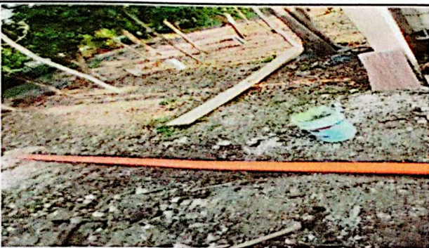
REPARACION DE TUBERIA PRINCIPAL DE DRENAJE
