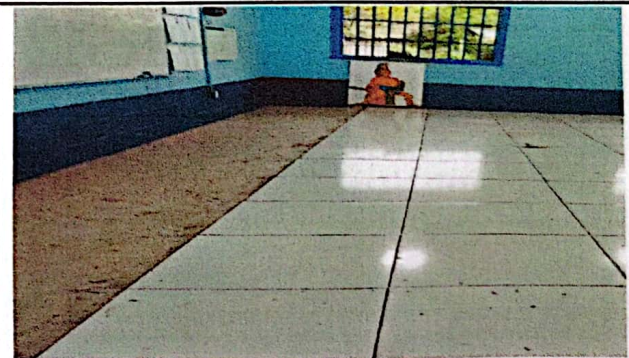
SUSTITUCIÓN DE CERÁMICO
