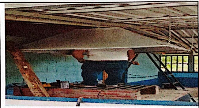
MANTENIMIENTO A ESTUFA RURAL
